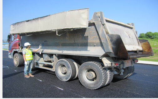
〈 운반장비의 적재함 옆면 중앙부의 혼합물 온도 측정구 및 측정 〉
